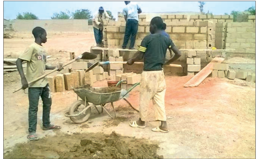
La construction d'une maternité à Sikoro dans la commune de Sanakoroba.
